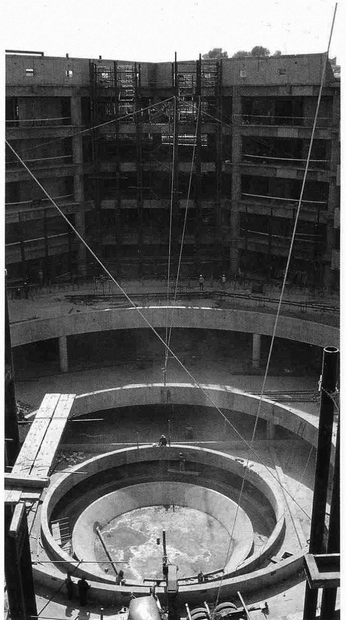
Vista de la plaza central y de la fuente, en construcción.
